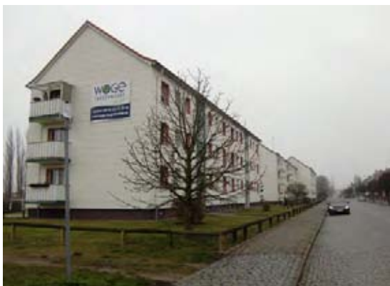
Wohnbauten der 60er Jahre an der Friedensstraße
