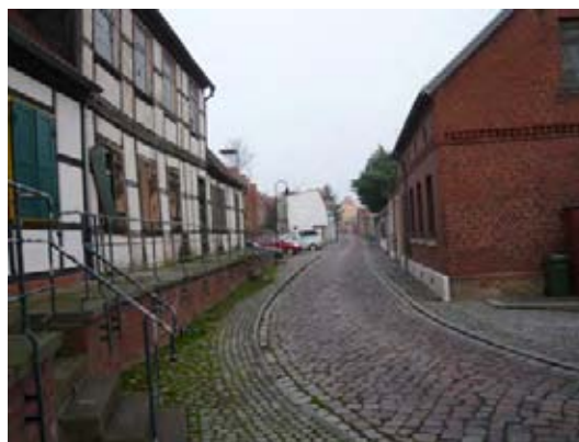
Substanzverfall (Gebäude links)
