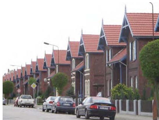
Werkwohnungsbau an der Friedensstraße
