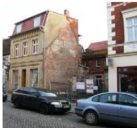
Baulücke an der Langen Straße
